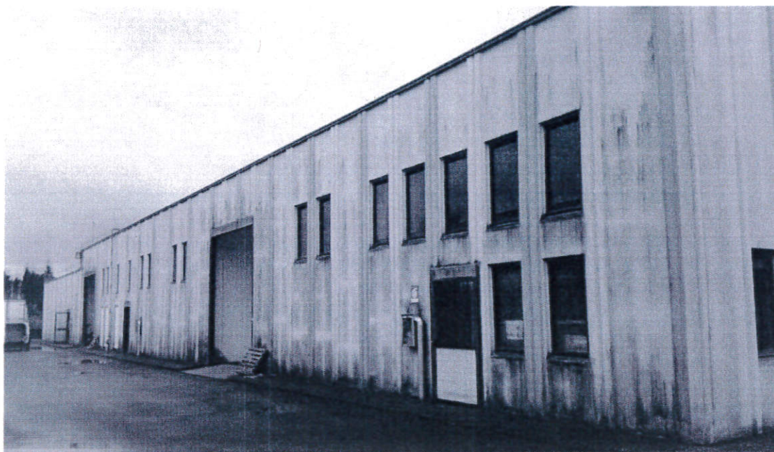
foto 3: Prospetto nord, ingressi locali di deposito e celle frigorifero
