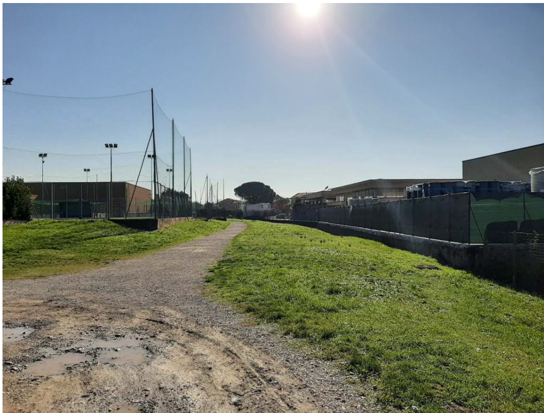
Immagine 6 – Vista da nuova viabilità di progetto verso stradello sterrato
