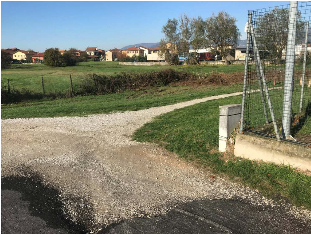
Immagine 14 – Particolare angolo recinzione stadio con colonna Enel
